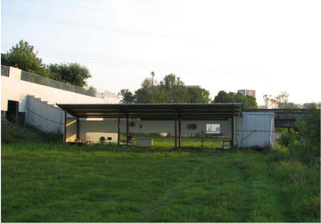
2008년 유림공원 공사로 유성천변에 이전한 활터 가건물 사옥
